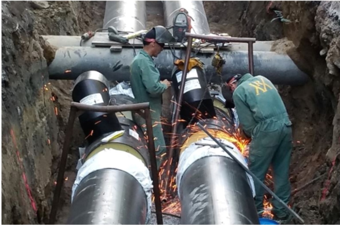
Exempelbild på svetsning av kulvertledning
